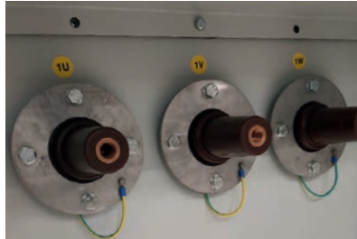
Caja de conexiones en el lado de AT con conectores enchufables
