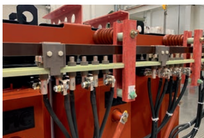
Cambiador de tomas en vacío
